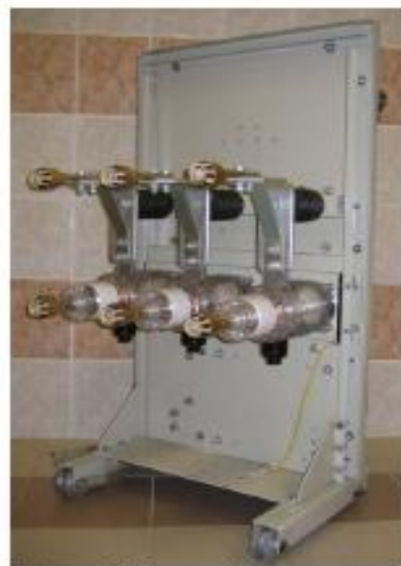
Рисунок 3. Вакуумный выключатель ВВ/TEL на выкатном элементе КРУ
