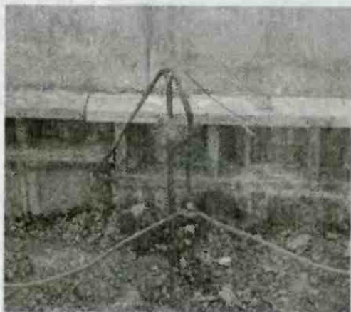
Рис. 7.15. Создание кольцевого заземления
