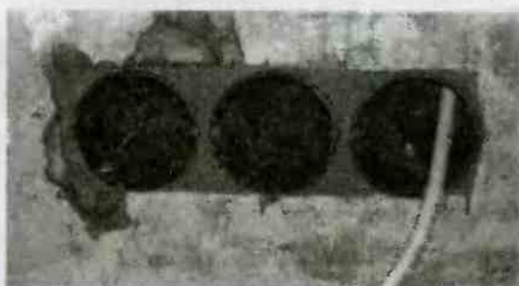
Рис. 3.6. Розетки закладываются на самых ранних этапах ремонта
