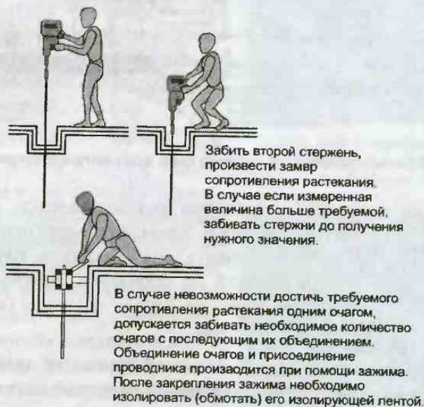
Рис. 7.16. Пример создания заземления
