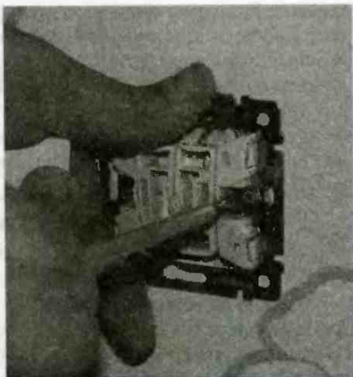
Рис. 3.38. Откручиваем крепление выключателя
