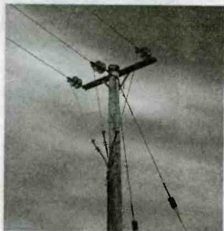
Рис. 7.28. Переход с воздушной линии на подземную
