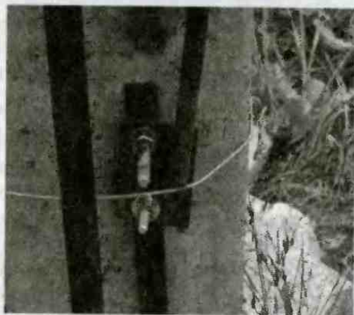
Рис. 7.18. Элементы в системе заземления свариваются внахлестку
