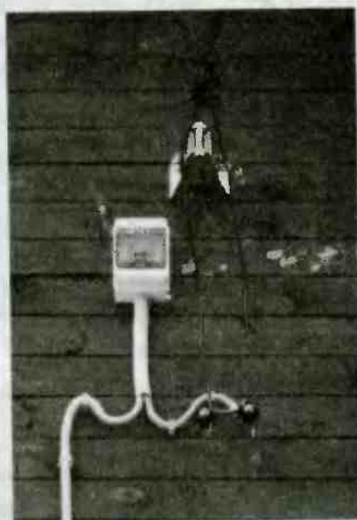
Рис. 7.25. Пример ввода в случае деревянного дома
