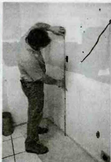
Рис. 4.18. Подготовительный этап перед началом работ крайне ответственен
