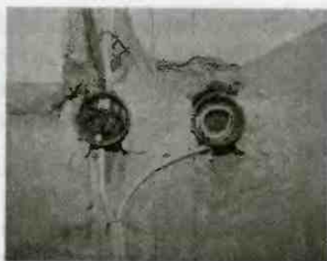
Рис. 6.21. Соединение проводов в распаечной коробке и отвод на будущую розетку
