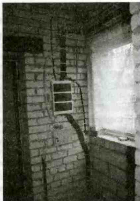
Рис. 4.8. Распределительный щиток
