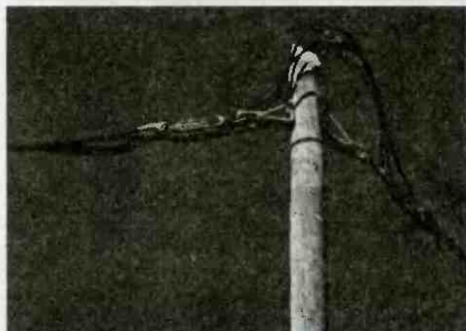
Рис. 7.22. Если до линии больше 25 метров, необходимо установить дополнительную опору, например обычный столб
