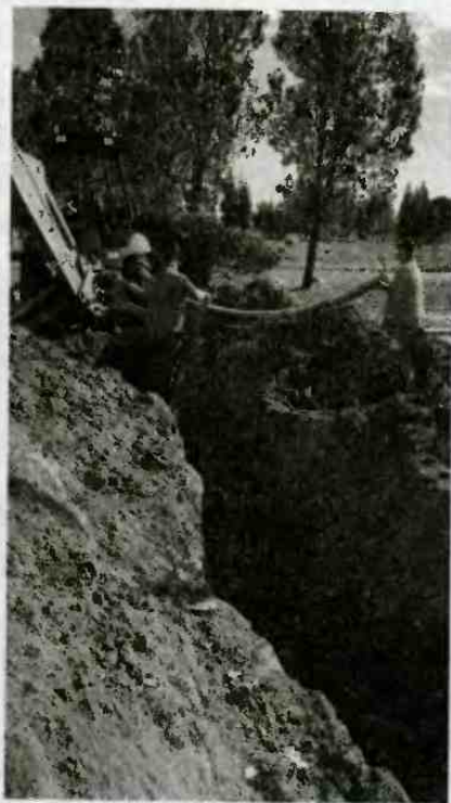
Рис. 7.6. Укладка трубы под кабель в траншею
