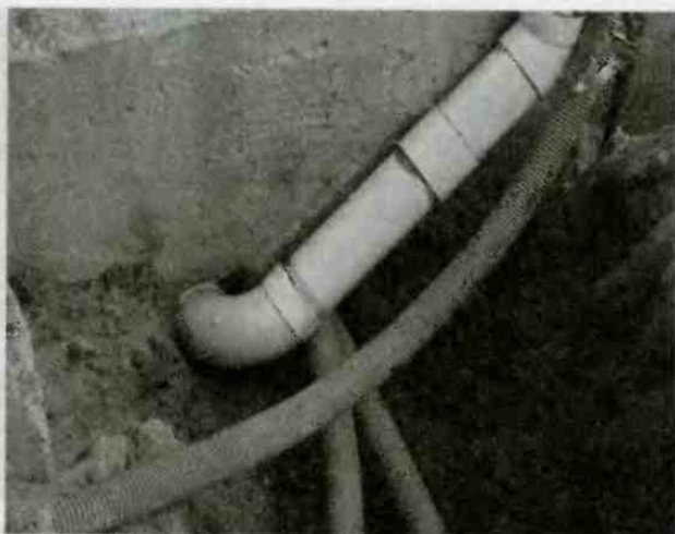
Рис. 7.31. Ввод кабеля в дом через стены
