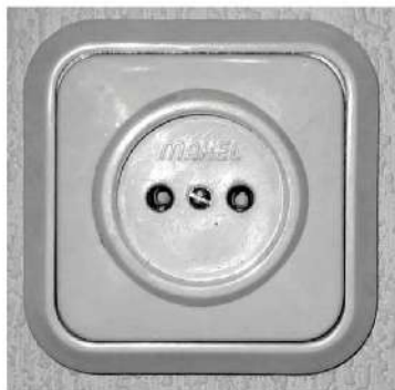
Рис. 74. Розетка для скрытой проводки, установленная в стене
