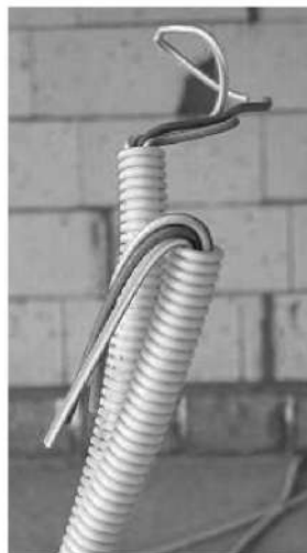
Рис. 12. Проводка в ПВХ-трубах
