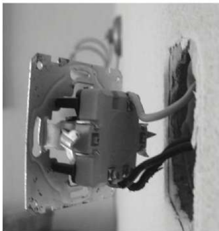
Рис. 60. Выключатель с подсоединенными электрическими проводами перед установкой на штатное место – в стену
