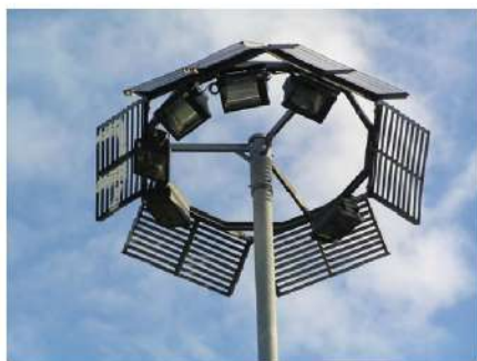
Рис. 90. Особенности расположения мощных светильников на мачте
