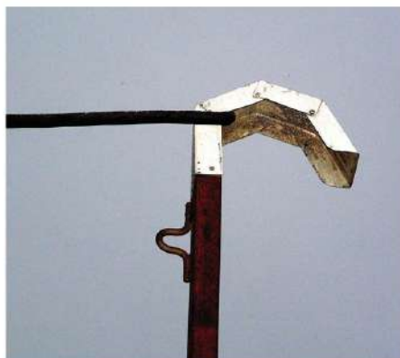
Рис. 92. Способ проводки кабеля и его заведение к устройству потребителя электроэнергии под углом 90^\circ
