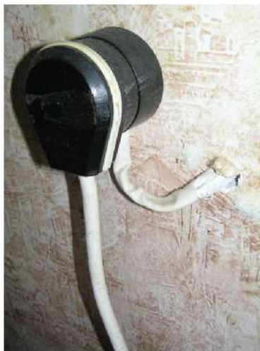
Рис. 80. Розетка мощной электрической плиты (с заземлением)
