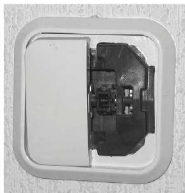
Рис. 63. Выключатель с одной установленной клавишей (промежуточный этап сборки выключателя)
