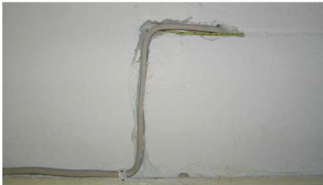
Рис. 76. Прокладка кабеля в гибридном исполнении
