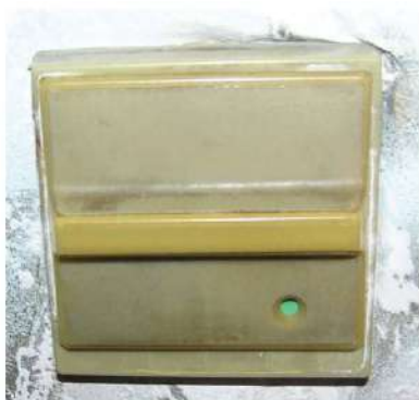
Рис. 64. Необычный клавишный выключатель с горизонтальным перемещением планки
