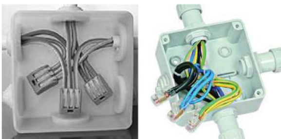
Рис. 14. Иллюстрации правильного и безопасного подключения проводов в клеммной коробке
