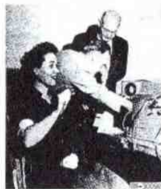
Рис. 1.2. Эксперимент по определению значения «отпускающего» (Let-go) тока с зажатым в руке испытуемого медным проводником
